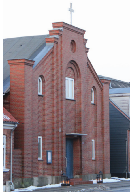
I 1930'erne blev et vindfang revet ned, og missionshuset i Varde blev udvidet med en stor portal ud mod gaden, som i dag adskiller huset fra andre huse i gadebilledet.
